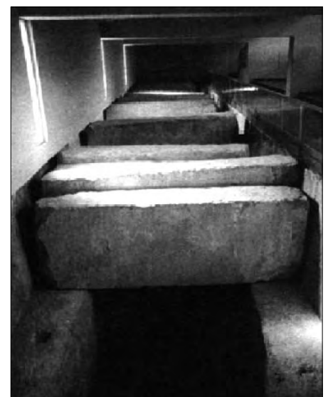
Granitriegel einer „Überlastungskammer“
