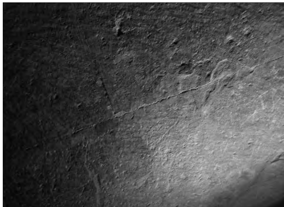
Die Steinverfugungen in der Großen Galerie lassen sich kaum erkennen. Man beachte, dass die riesigen Granitblöcke schräg gesetzt sind, im selben Winkel wie der Aufweg der Galerie.
