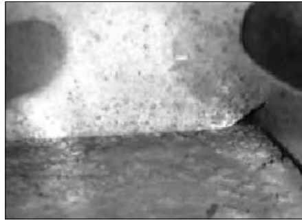
Rechts: Das Ende des Schachtes mit dem Verschlussstein, der zwei unterschiedlich lange Metallklammern enthält.
