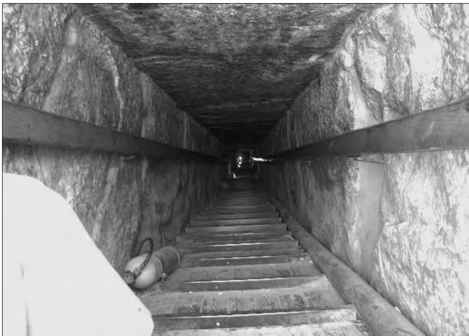
Der abwärts führende Gang hat gerade mal einen Durchmesser von rund einem Quadratmeter und führt rund 65 Meter in die Tiefe.
