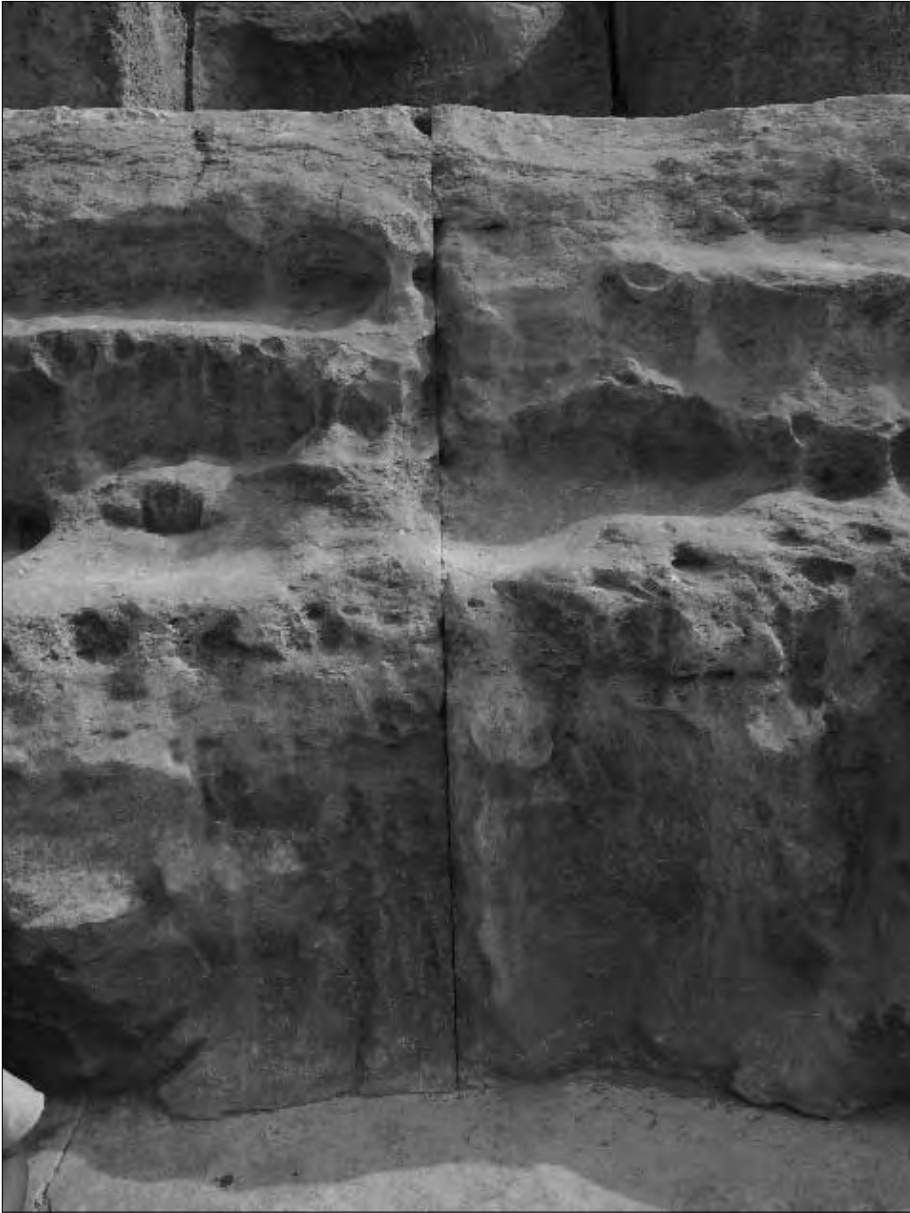
Hier kann man trotz der Verwitterung erkennen, dass auch diese Blöcke millimetergenau aneinandergesetzt worden sind.
