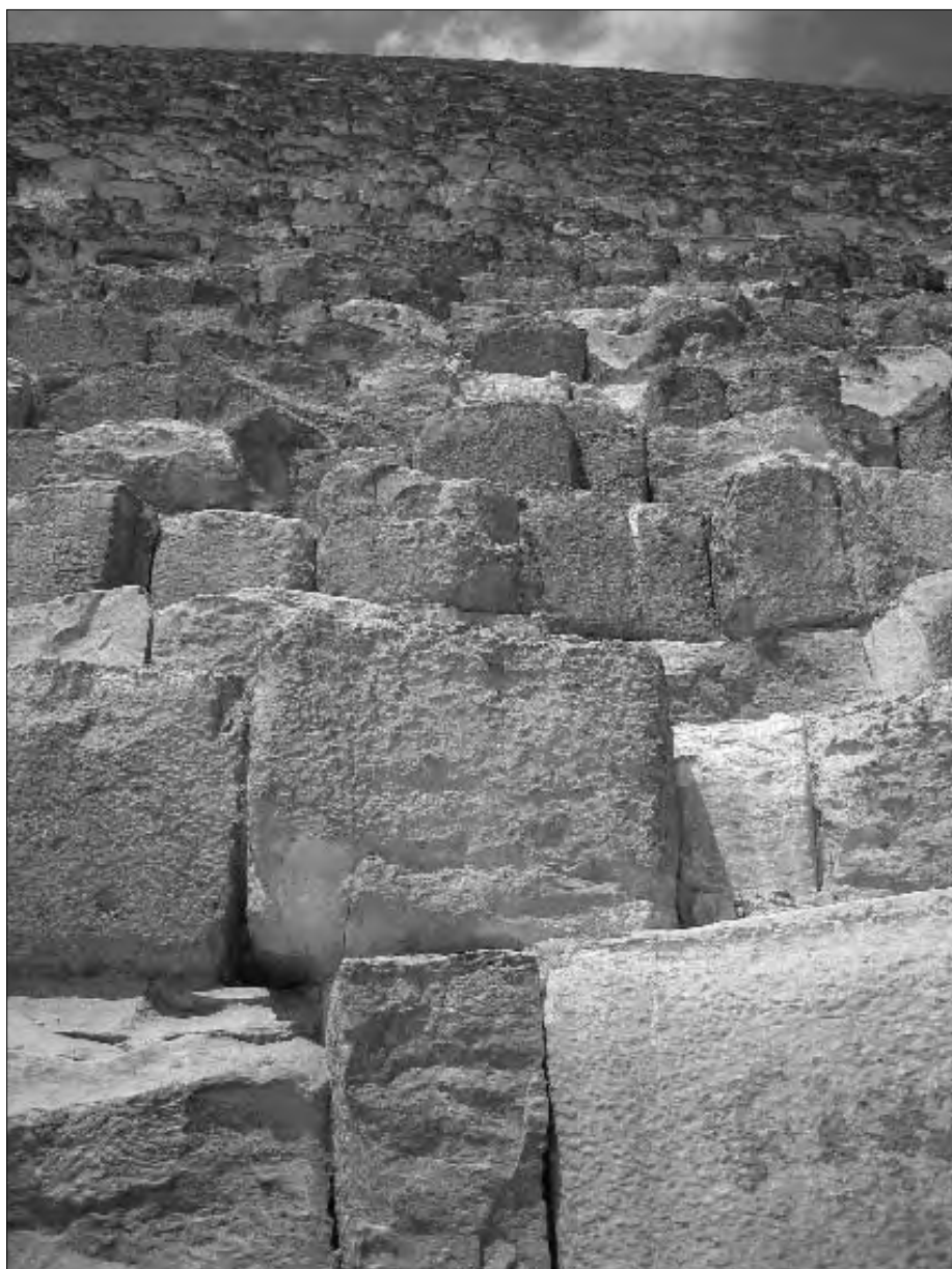
Die Steinblöcke der Cheopspyramide wirken nur roh bearbeitet und ziemlich wahllos aufeinandergetürmt, aufgrund der fehlenden Verkleidung. In Wirklichkeit sehen sie nur aufgrund von jahrtausendelanger Verwitterung heute so aus.
