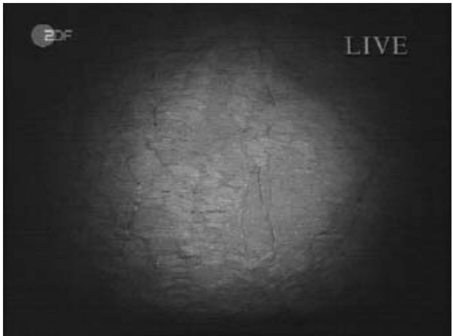
Der Verschlussstein hinter dem Verschlussstein. Er scheint nicht so glatt poliert zu sein wie der durchbohrte. Man erkennt Risse im Material.
