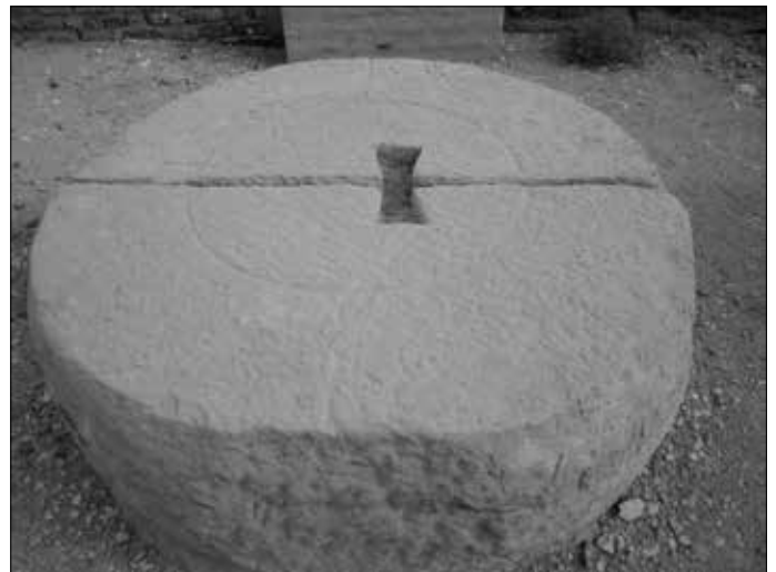
Klammer-Aussparung im Merenptah-Tempel (Luxor-Westbank)-
