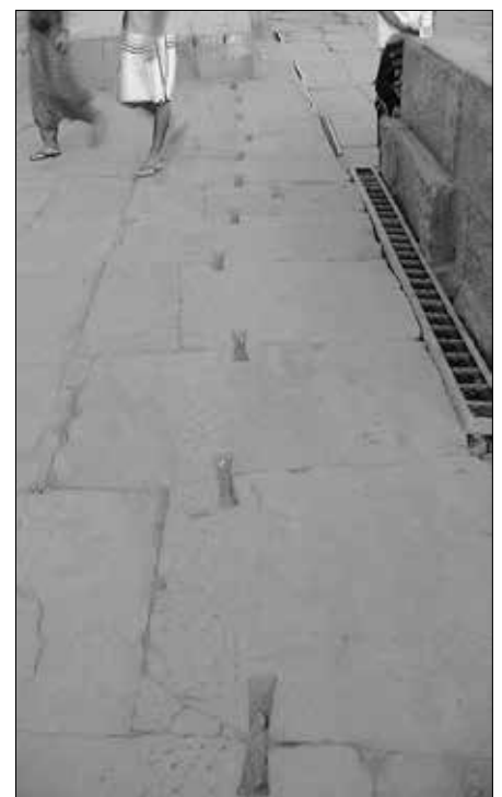
Klammer-Aussparungen in Kom Ombo (Doppeltempel).
