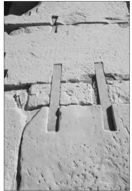
Ausgefüllte Klammer-Aussparungen auf dem Dach des restaurierten Hathor-Tempels in Deir al-Madina mit Oberflächenrost. Rechts: heutige Klammern.
