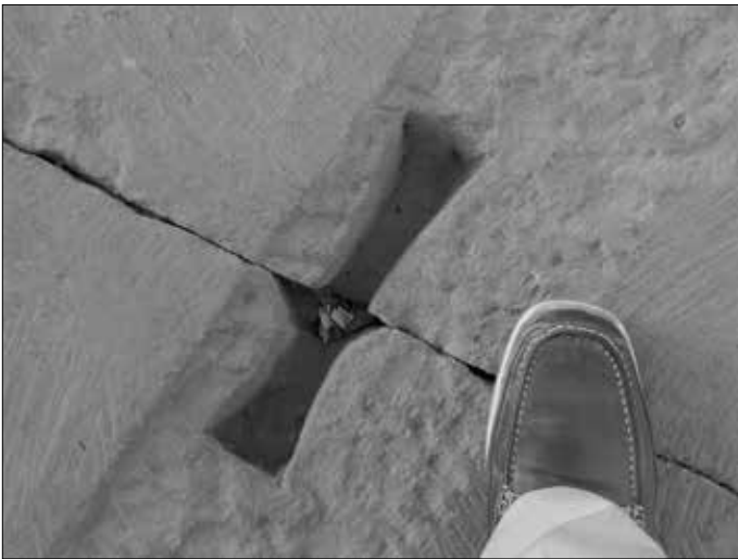
Klammer-Aussparungen in Kom Ombo (Doppeltempel).
