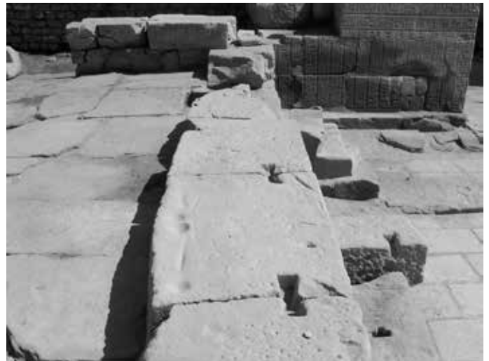
Klammer-Aussparungen in Edfu (Horus-Tempel).
