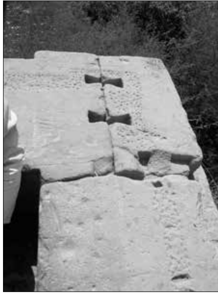
Klammer-Aussparungen auf Philae. Links und Mitte: Hathor-Tempel. Rechts: Trajan-Tempel.
