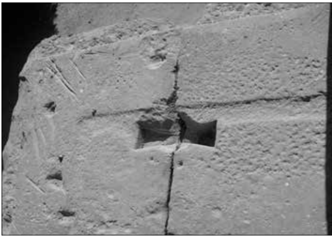
Klammer-Aussparungen in Deir el-Schalwit (Isis-Tempel).
