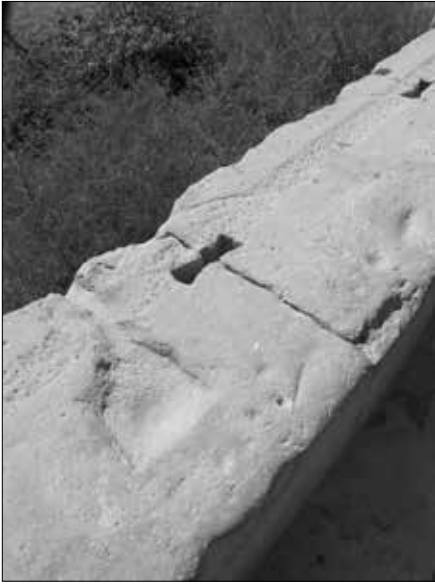
Klammer-Aussparungen auf Philae. Links und Mitte: Hathor-Tempel. Rechts: Trajan-Tempel.
