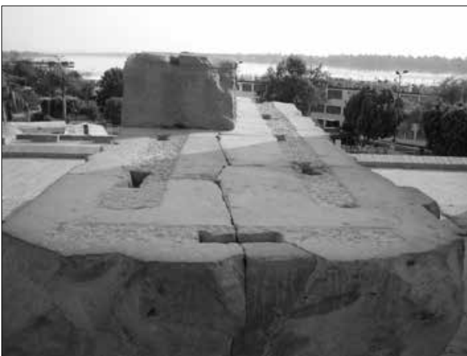
Klammer-Aussparungen in Kom Ombo (Doppeltempel).
