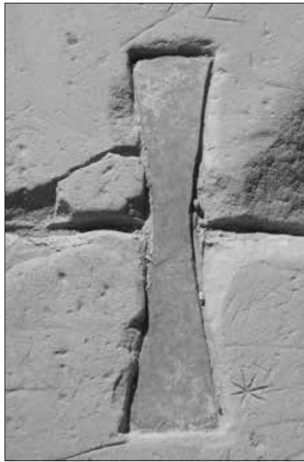
Ausgefüllte Klammer-Aussparungen auf dem Dach des restaurierten Hathor-Tempels in Deir al-Madina mit Oberflächenrost. Rechts: heutige Klammern.
