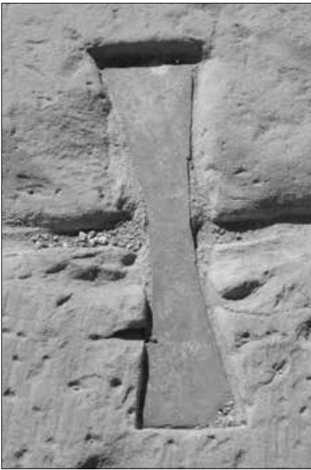
Ausgefüllte Klammer-Aussparungen auf dem Dach des restaurierten Hathor-Tempels in Deir al-Madina mit Oberflächenrost. Rechts: heutige Klammern.
