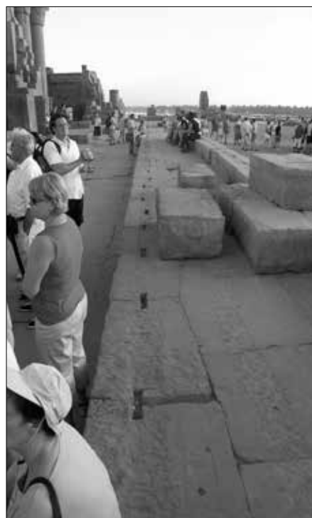
Klammer-Aussparungen in Kom Ombo (Doppeltempel).
