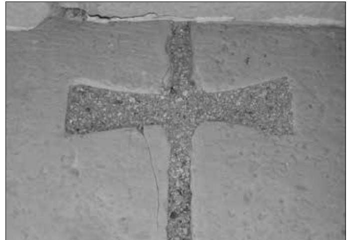
Links: Eine weitere ausgefüllte Klammer-Aussparung (Hathor-Tempel in Deir al-Madina). Rechts: mit Sand ausgefüllte Aussparung.
