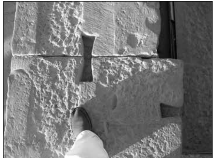
Klammer-Aussparungen in Kom Ombo (Doppeltempel).
