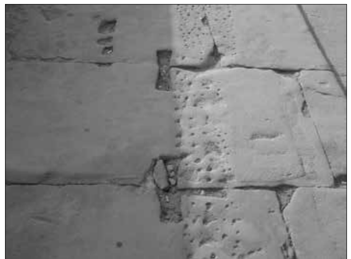
Klammer-Aussparungen in Kom Ombo (Doppeltempel).
