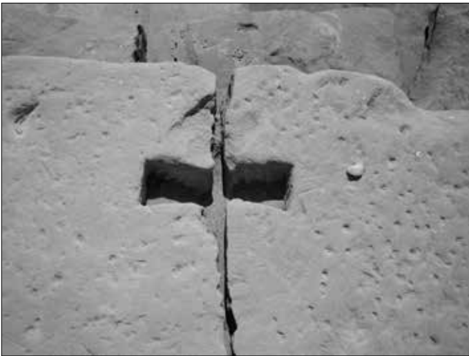
Klammer-Aussparungen in Edfu (Horus-Tempel).
