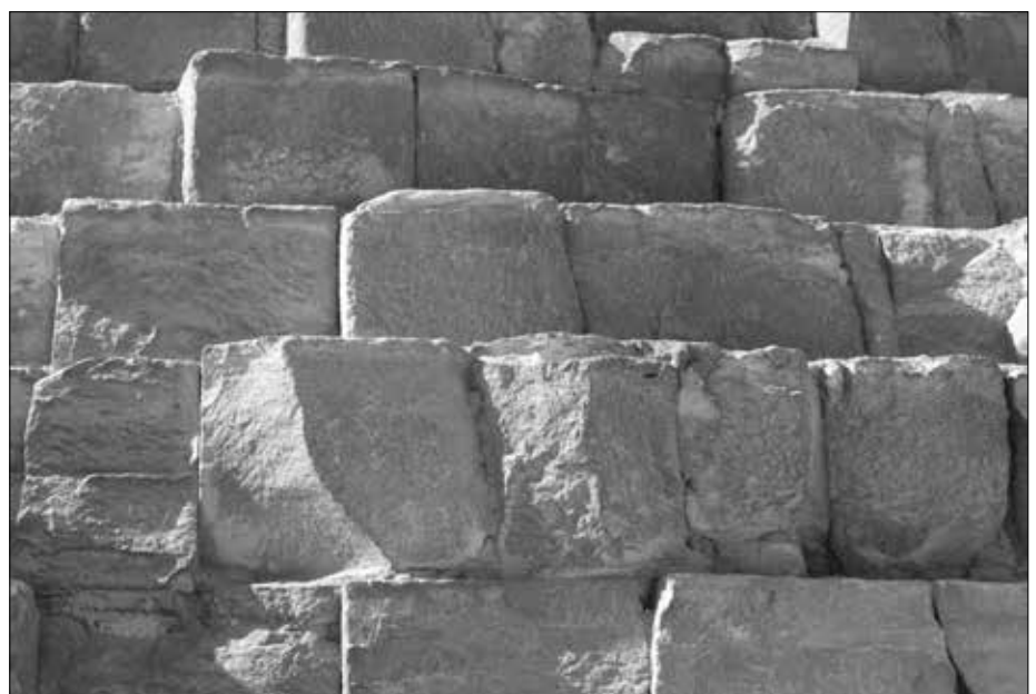
Abb. 7: Cheopspyramide, Ostseite. Abgesehen davon, dass auch hier die verbauten Steinblöcke unterschiedlich groß sind, erkennt man, dass sie nicht zwingend aus demselben Steinbruch stammen.
