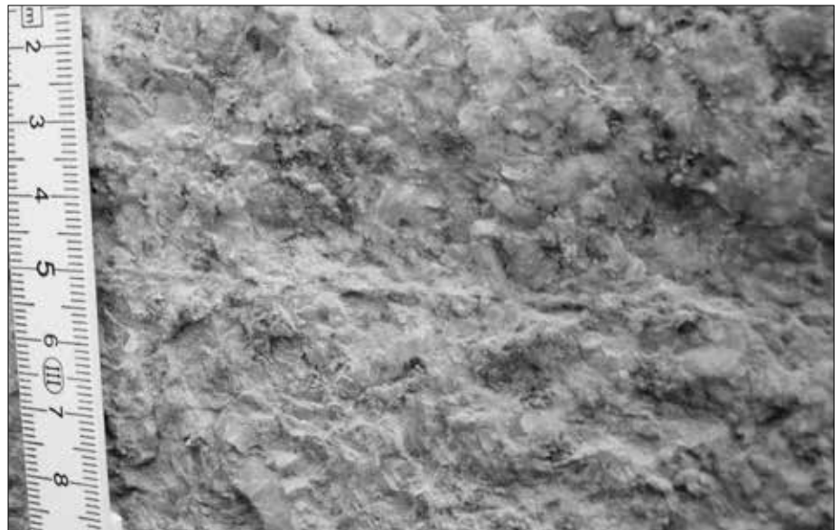
Chephren-Tempel: Granitblöcke ohne Trennfuge, aber mit blockübergreifenden Strukturen. Die beiden Blöcke liegen etwa bei Zentimeter 5 aufeinander.
