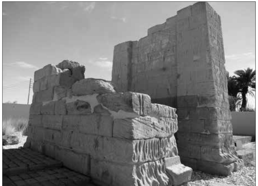
Das ehemalige Eingangstor (Innenseite).
