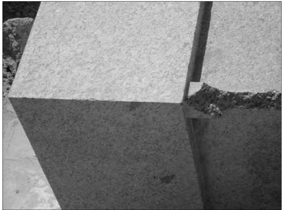
Man erkennt, wie überaus exakt gearbeitet wurde. Rechts ist ein Teil der Verzierungen weggebrochen. Granit ist ein höchst sprödes, empfindliches Gestein!
