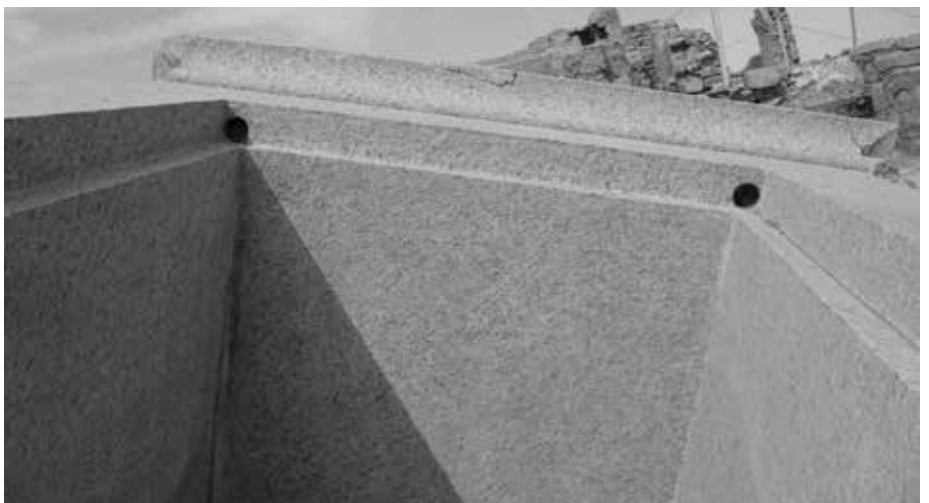
Ein Blick ins Innere zeigt die ausgesprochen exakte Bearbeitung. Oben und unten befinden sich in den Ecken je 6 cm durchmessende Kernbohrungen, die wohl einst der Aufnahme von Türangeln dienten.
