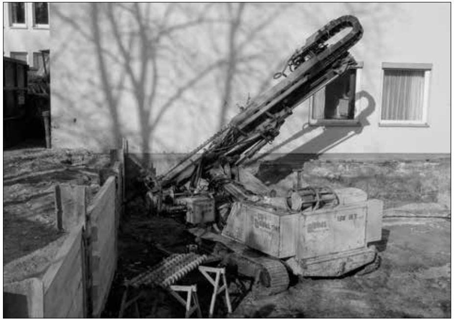
Mit solchen Maschinen erzeugt man heute Kernbohrungen in Beton oder Stein.
