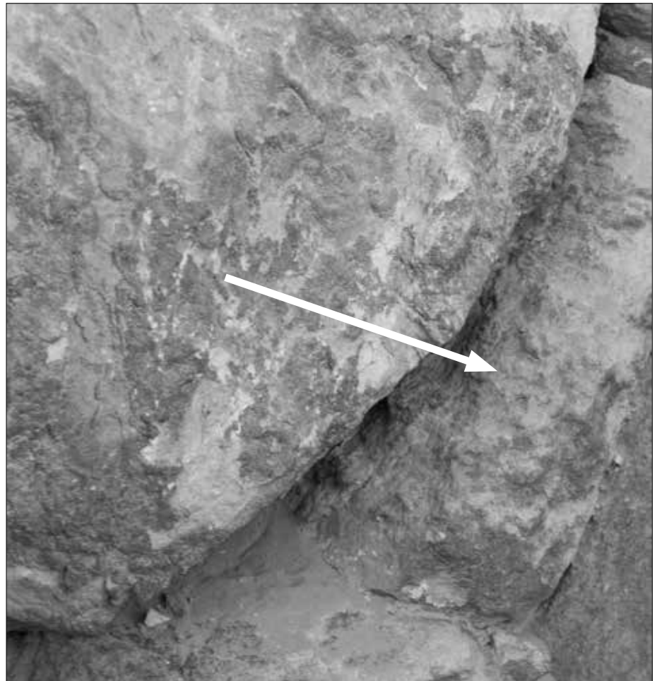
Ein weiterer breiter Spalt an der Mykerinos-Pyramide, der mit Mörtel verfüllt wurde. (Hier: Ostseite)
