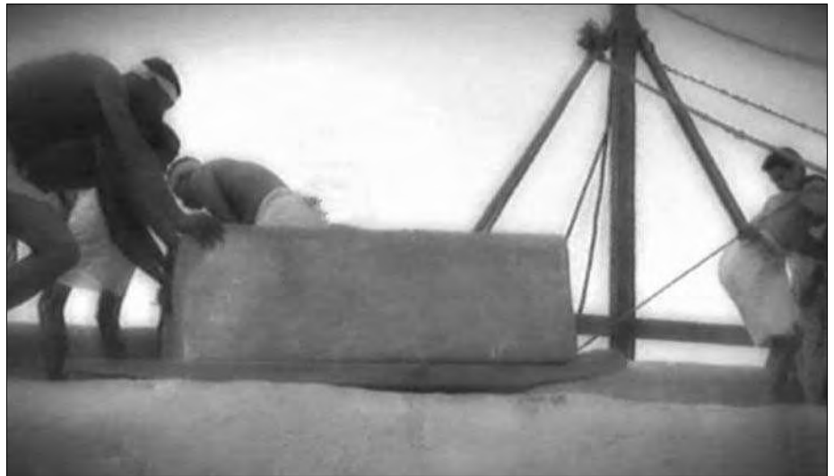
Der Steinblocktransport hat einen Holzkran erreicht.
