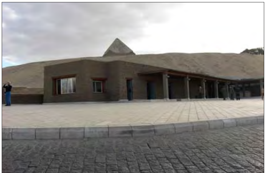
In diesem Gebäude erhält man jetzt die Eintrittskarten und muss vor dem Betreten des Gizeh-Plateaus eine Sicherheitsschleuse durchlaufen.
