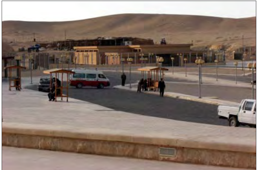
Der Parkplatz vor dem Zugang zum Gizeh-Plateau. Im Hintergrund die ersten Rohbauteile des geplanten neuen Ägyptischen Museums.
