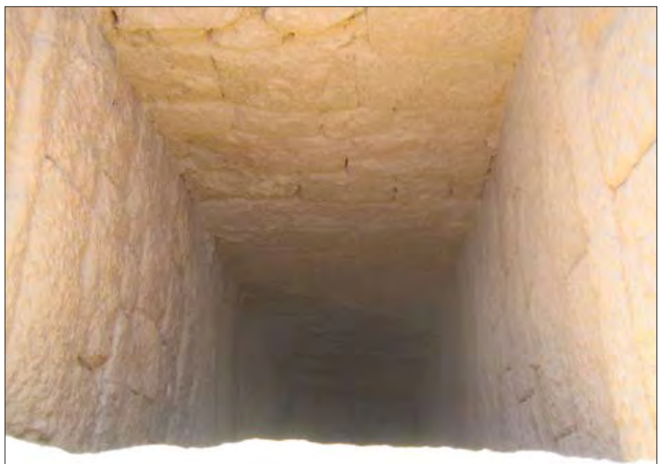
Einer der Schächte. Im oberen Bereich wurde er noch aufgemauert.
