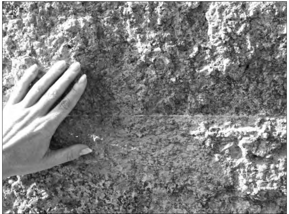
Fugenübergreifende Strukturen im Granit, die sich selbst auf kleinste Verfärbungen auswirken. Man beachte auch die Fuge, die nur Bruchteile von einem Millimeter breit ist! (Chephren-Tempel)
