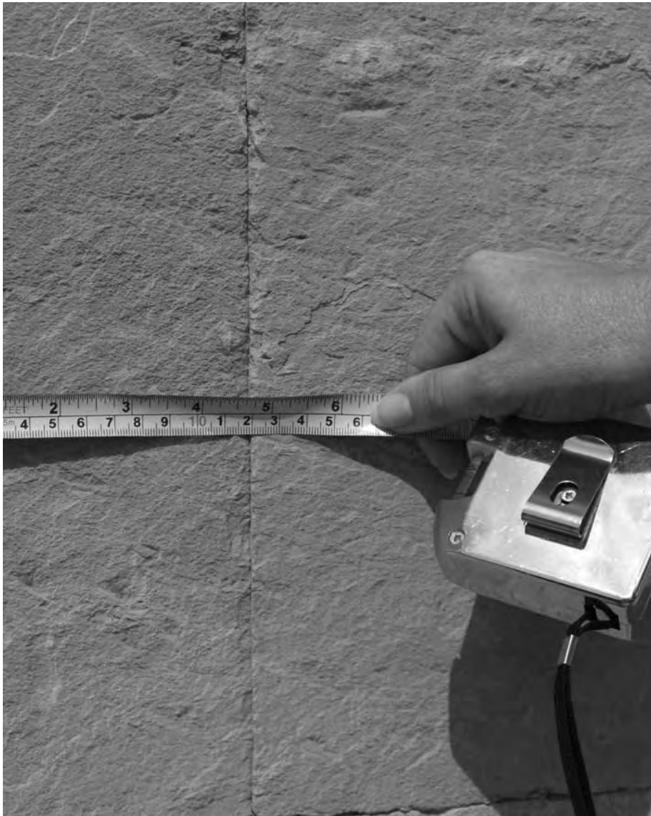
Auch hier (zwar schwächer ausgeprägt, aber noch erkennbar) blockübergreifende Steinstrukturen. Man beachte die kaum messbare Fuge zwischen den Blöcken (Mastabafeld westlich der Cheopspyramide).
