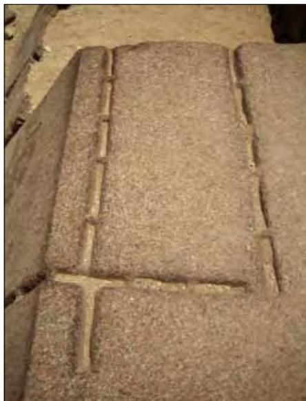
*Um die Chephren-Pyramide liegen Granitblöcke der ehemaligen Verkleidung, an denen Steinräuber vergeblich versucht haben, sie durch Einkerbungen in handlichere Brocken zu spalten.*
