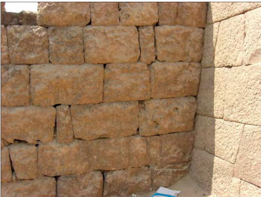
Zwei Mauern, zwei Bauarten. In der linken Mauer sind die Steine relativ einfach zusammengesetzt, in der rechten hingegen fast fugenlos.
