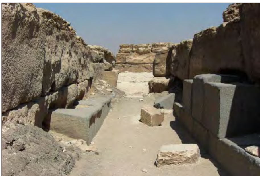
Der Totentempel des Mykerinos. Am Boden links und rechts Granitblöcke. Die oberen Mauerbereiche sind arg in Mitleidenschaft gezogen. Solche Steinblöcke lassen sich nur durch Wasserfluten so durcheinander werfen, das schafft kein Erdbeben und kein Sandsturm!
